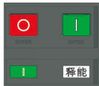
断路器合闸且无储能状态
