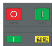
断路器合闸且已储能完毕状态
